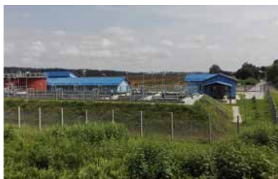
▲ Úplne nová čistiareň odpadových vôd pri Bánovciach nad Ondavou.
