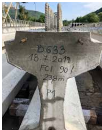
▲ Na bočnej strane prefabrikátu je napísaný „rodný list“ – dátum výroby a typ produktu.
