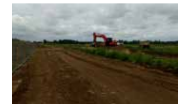
▲ Zemné práce na zákazke Konopiská pri Bratislave-Čunove.
