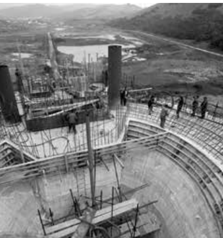
▲ Vzácnny záber z budovania vodného diela.
