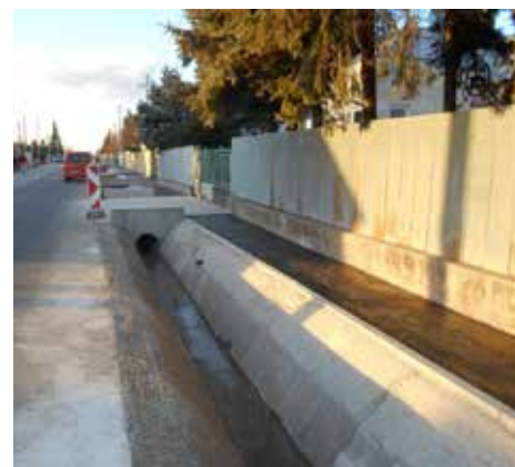
▲ Výsledkom stavby je aj modernejší, upravenejší vzhľad obcí.
